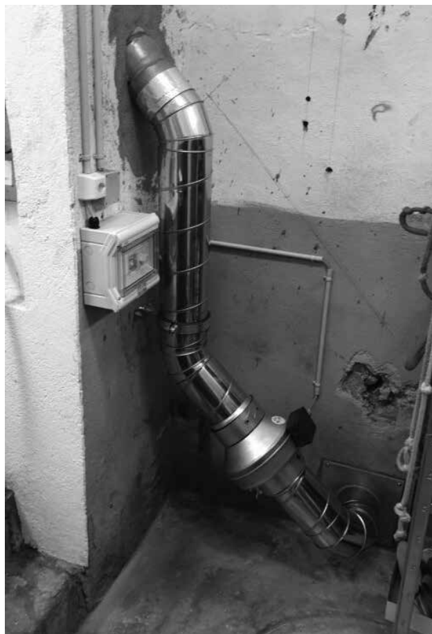
Die Radonwerte lassen sich gut mit Belüftungs- und Abdichtungsmassnahmen der Kellerräume verbessern, wie hier im Schulhaus Schwändi.
