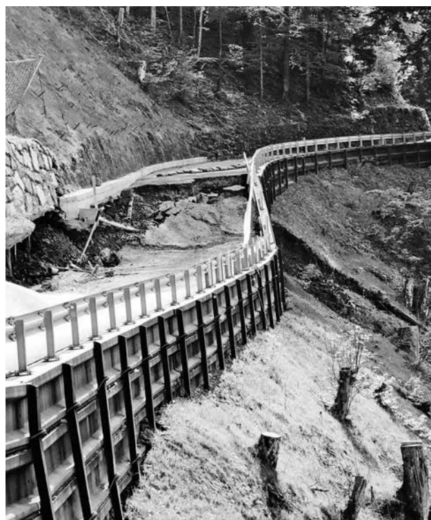
Durch die Rutschung gab es weitere Senkungen und Risse in der Strasse und im Gelände. Foto: GFO Glarus Süd
