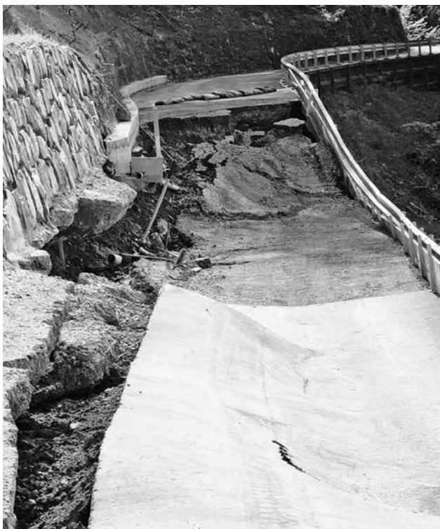
Durch die Rutschung gab es weitere Senkungen und Risse in der Strasse und im Gelände. Foto: GFO Glarus Süd
