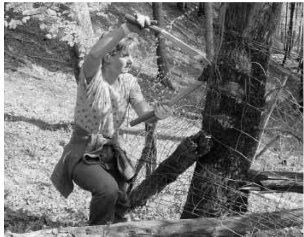
Mit grossen Scheren wurde der Maschendrahtzaun verkleinert und anschliessend zusammengerollt
