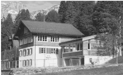
Auf der Schliessungsliste: Gesamtschule Braunwald, heute 23 Kinder.
