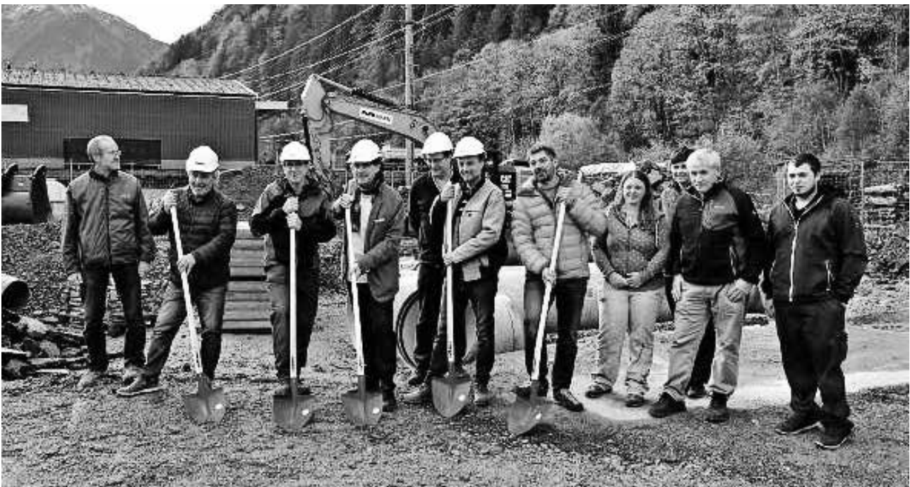
Von den Bauarbeitern bis zu den Vorstandsmitgliedern und Metzger Kevin Moser (ganz rechts) freut man sich über die Realisation des Projektes. Foto: Barbara Bäuerle-Rhyner
