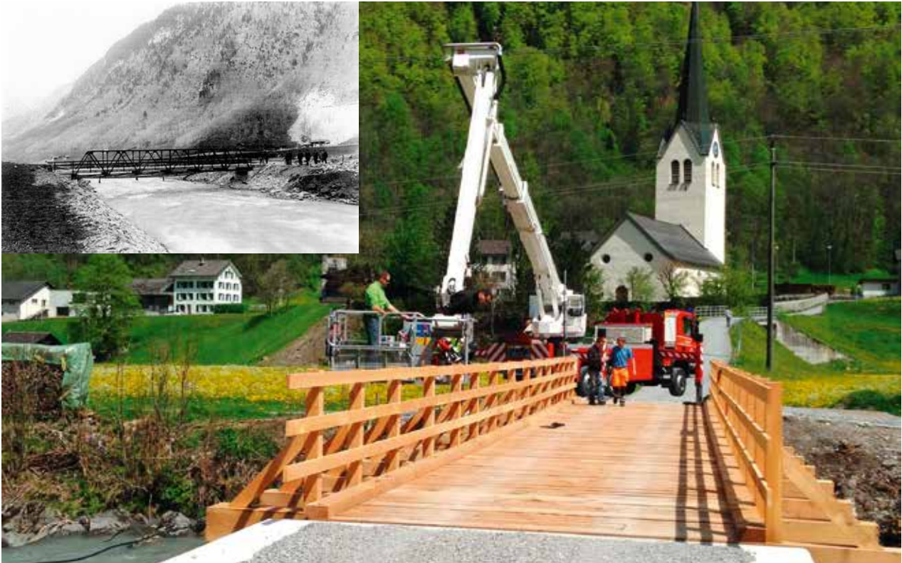
Foto neue Brücke: Claudia Kock Marti; Foto alte Brücke: zVg. von Heinrich Hämmerli
