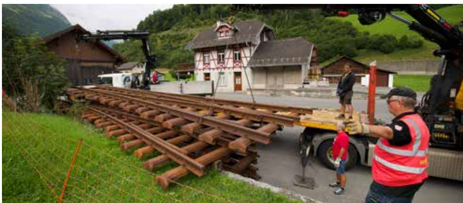
Abladen von Weichen bei der Station Elm am 18. August 2018. © Comet Photoshopping, Dieter Enz
