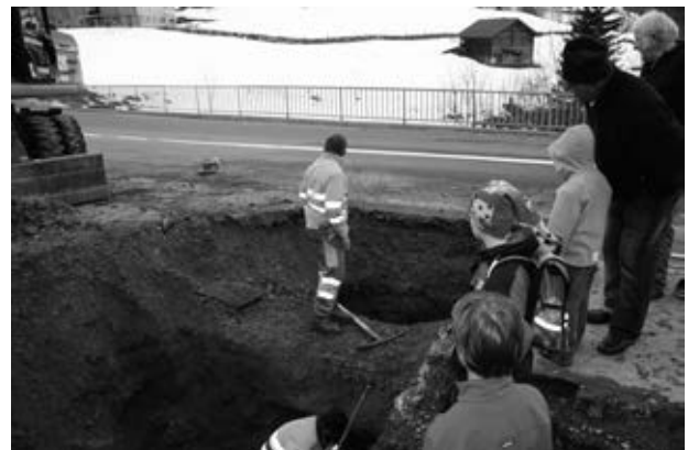
Auch Zuschauer begutachteten das tiefe «Doppel-Loch» neben der Strasse.
