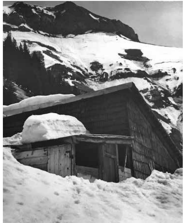
«Duggelboden, die alte Hütte». Foto: Lieni Schuler
