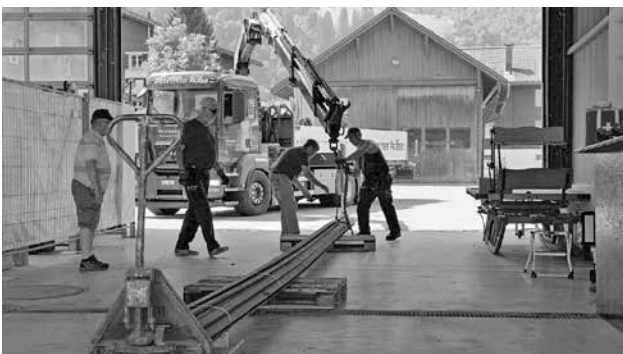
Foto: Bereitstellen der Schienen im SeTB-Depot Elm. Im Hintergrund die historische SeTB-Remise. © Comet Photoshopping, Dieter Enz
