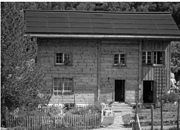
Totalsanierung der Aussenfassade mit Solaranlage auf dem ganzen Dach der Südseite von Ueli und Annemarie Walser, Krauch.
