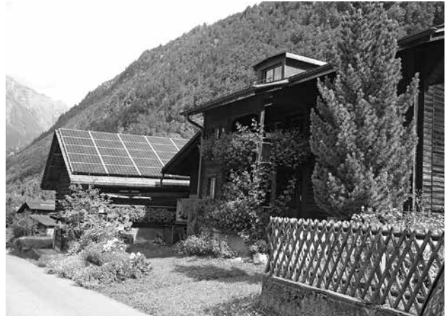
Neue Solaranlage auf dem ganzen Dach eines Stalles der Südseite von Ursula und Fridolin Freitag-Marti, Auen.
