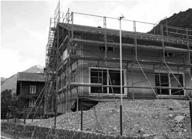
Neubau Einfamilienhaus von Christian und Edith Schuler, Dorfstrasse.
