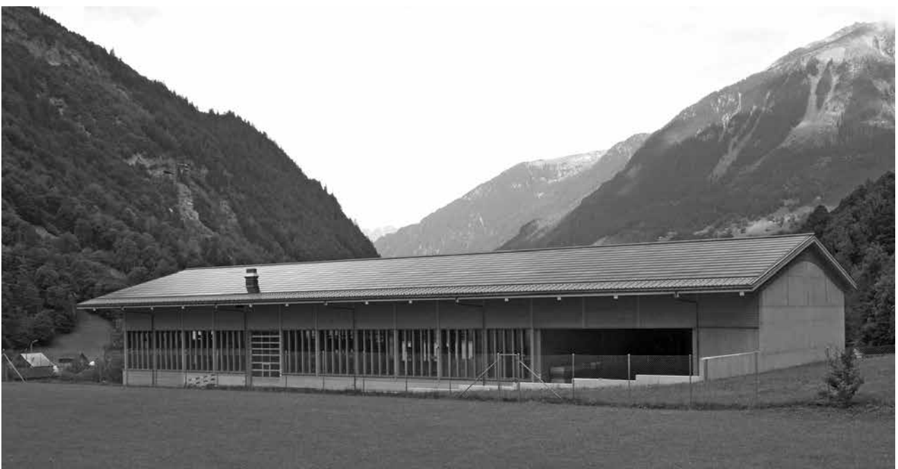
Die Photovoltaik-Anlage (185 kWp) über die gesamte Dachseite der Südfassade dient zur Stromproduktion für das gesamte Areal (Holzbau, Bauunternehmung und Betonanlage).
