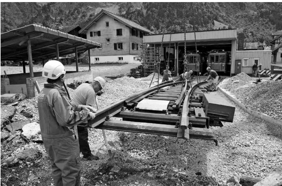
Positionieren der Rechtsweiche. Foto: Dieter Enz © Comet Photoshopping, Dieter Enz
