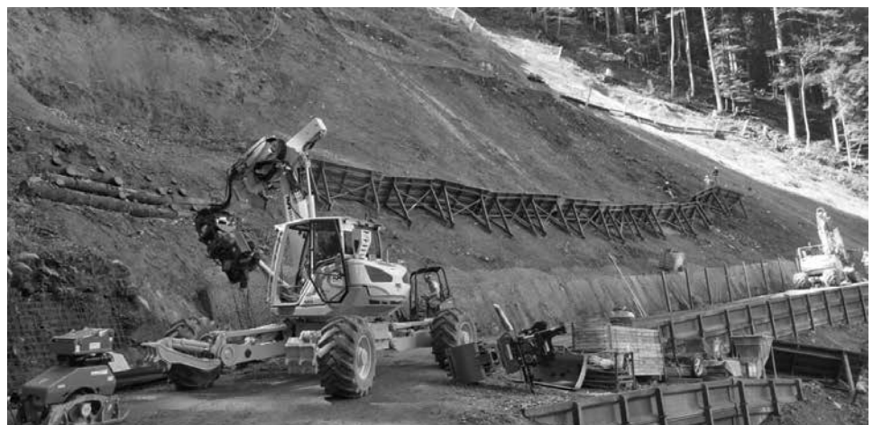
Arbeiten im steilen Gelände: Unter grossem Zeitdruck setzen die Bauarbeiter insgesamt 750 Anker, um das Gelände und die Strasse ins Niederental zu sichern.
