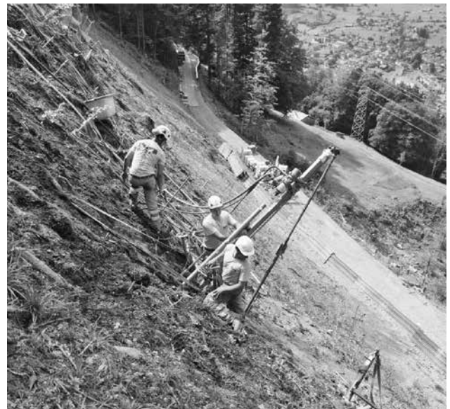
Arbeiten im steilen Gelände: Unter grossem Zeitdruck setzen die Bauarbeiter insgesamt 750 Anker, um das Gelände und die Strasse ins Niederental zu sichern.
